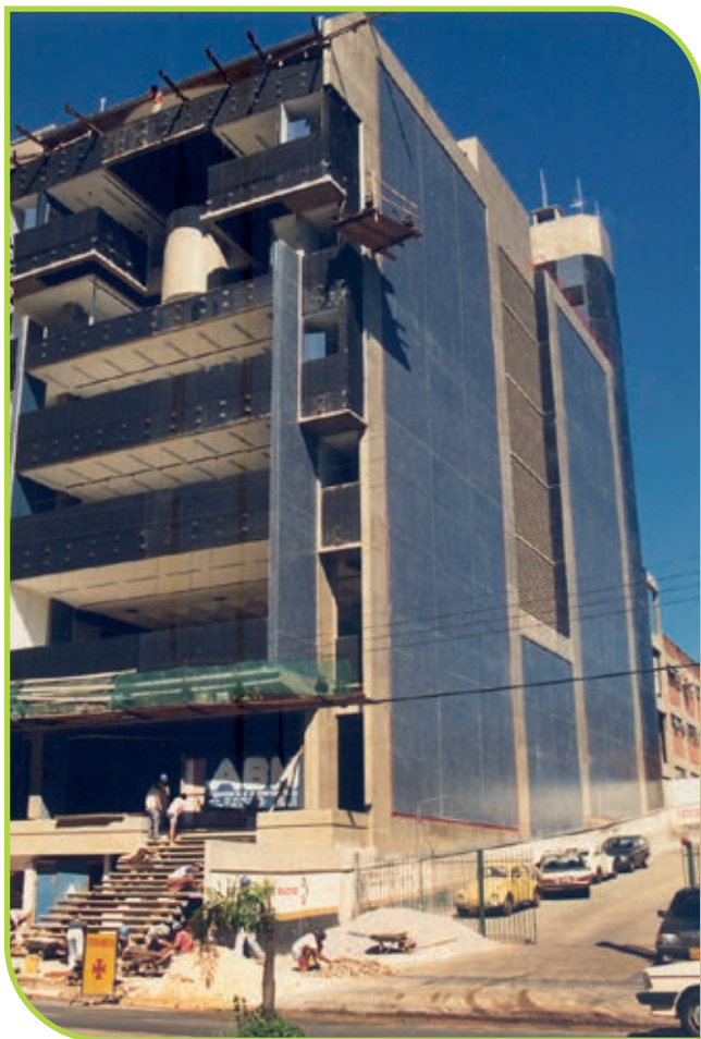
Construção da nova sede administrativa, em 1989.
